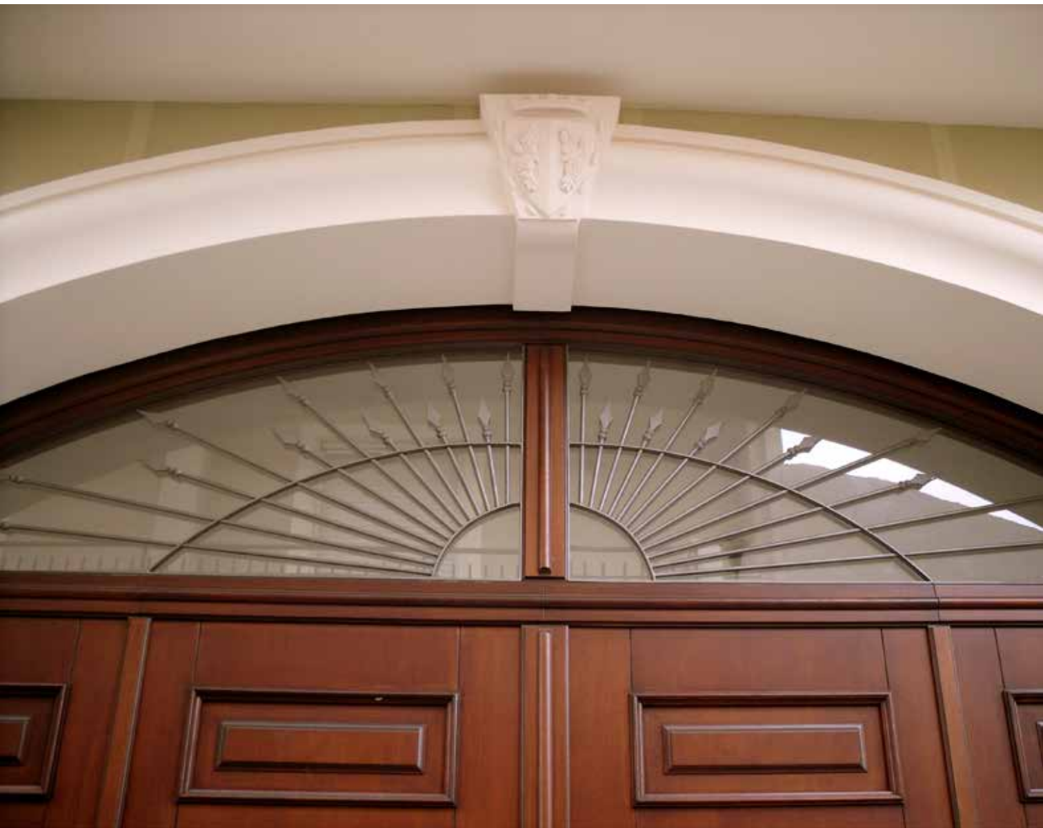
Particolare sopraluce con grata
